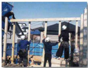
▼ 上棟・骨組み
