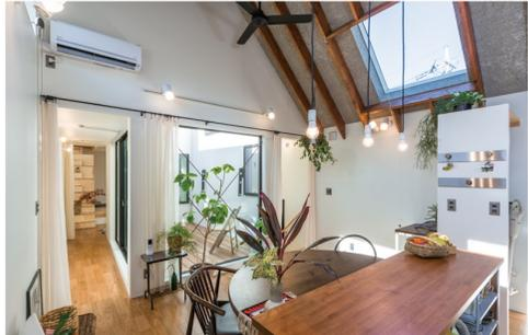
2階食卓間は高さ3.8mの勾配天井で、垂木梁しの開放的な空間。天井は断熱性・耐火性に優れた木毛セメント板を採用しています。
