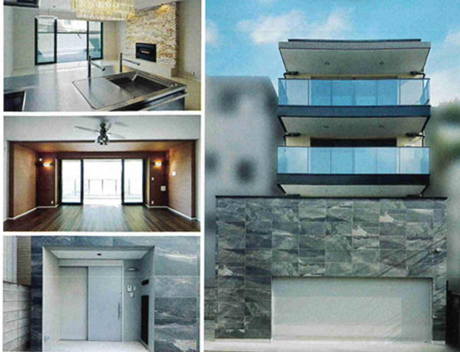
RC造4階建ての施工例。ビルトインガレージの外壁にはトランプーンを思わせる印象的なタイルを採用。同社は木造のみならず、RC造やS造など様々な構造に対応している
